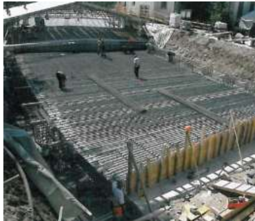
Beispiel Deckelbauweise Tagbau
