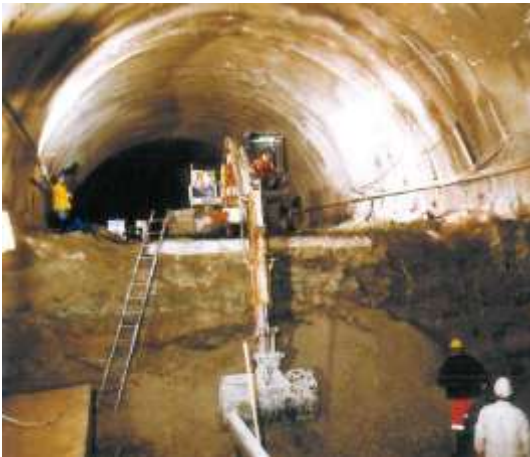
Beispiel Teilausbruch bergmännisch
