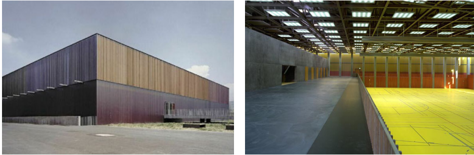
Sporthalle Herti, Zug, ZG | Bétrix + Consolascio, Architekten, Erlenbach
