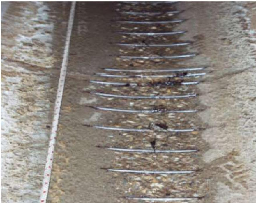
Abrasionsschäden an der Rohrsohle
