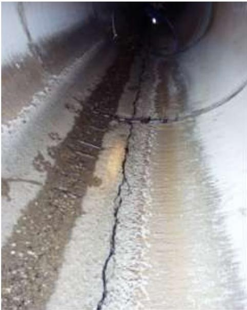
Längsriss in der Rohrsohle
