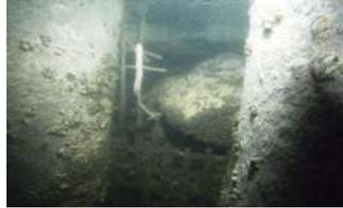
Im Unterwasserbereich sind hinter die Pfähle Armierungsnetze gestellt, welche mit Blocksteinen gefüllt sind. Die Armierungsnetze sind stellenweise gebrochen (Bild rechts), was zu grösseren Hohlräumbildungen führte. Durch die Druck- und Sogwirkung des Wassers ist die Hinterfüllung der Ufermauer bereits stark aufgelockert. Einbrüche an der Terrainoberfläche sind die Folge.
